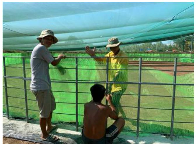
**Un borde de hormigón proporciona soporte a los postes verticales y la integridad de un tanque redondo de hasta 32 metros de diámetro.**
